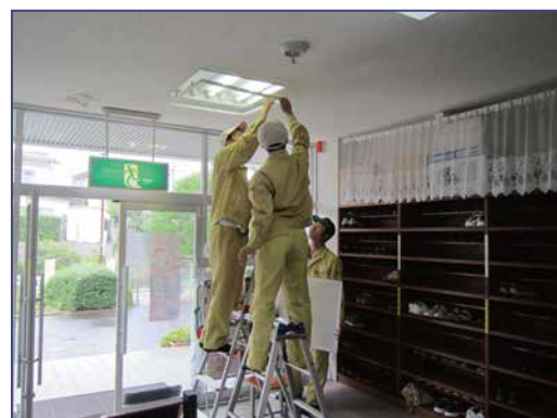
照明器具のメンテナンスをする 松江工業高校「電ボラ」隊
